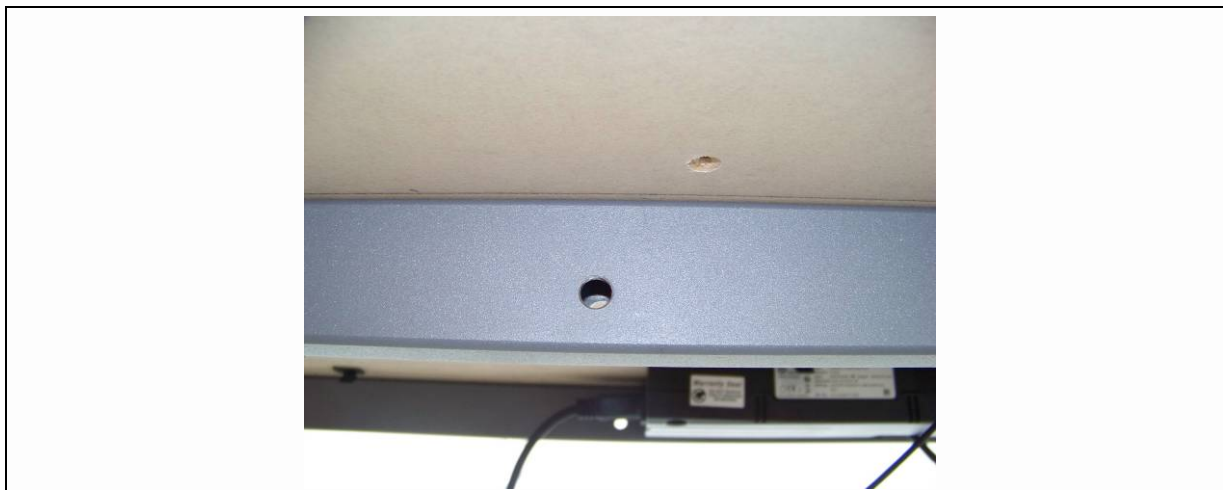
Abbildung 3: Bohrlöcher zur Montage der Sensoreinheit
